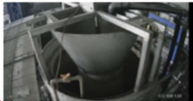
Imagen de ejemplo Vista de cámara en el tanque de cristalización
