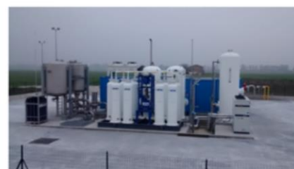
Figura 13 Vista generale Upgrading
