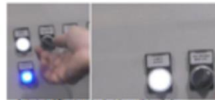
8. Impianto di filtraggio: premere il pulsante "On".
